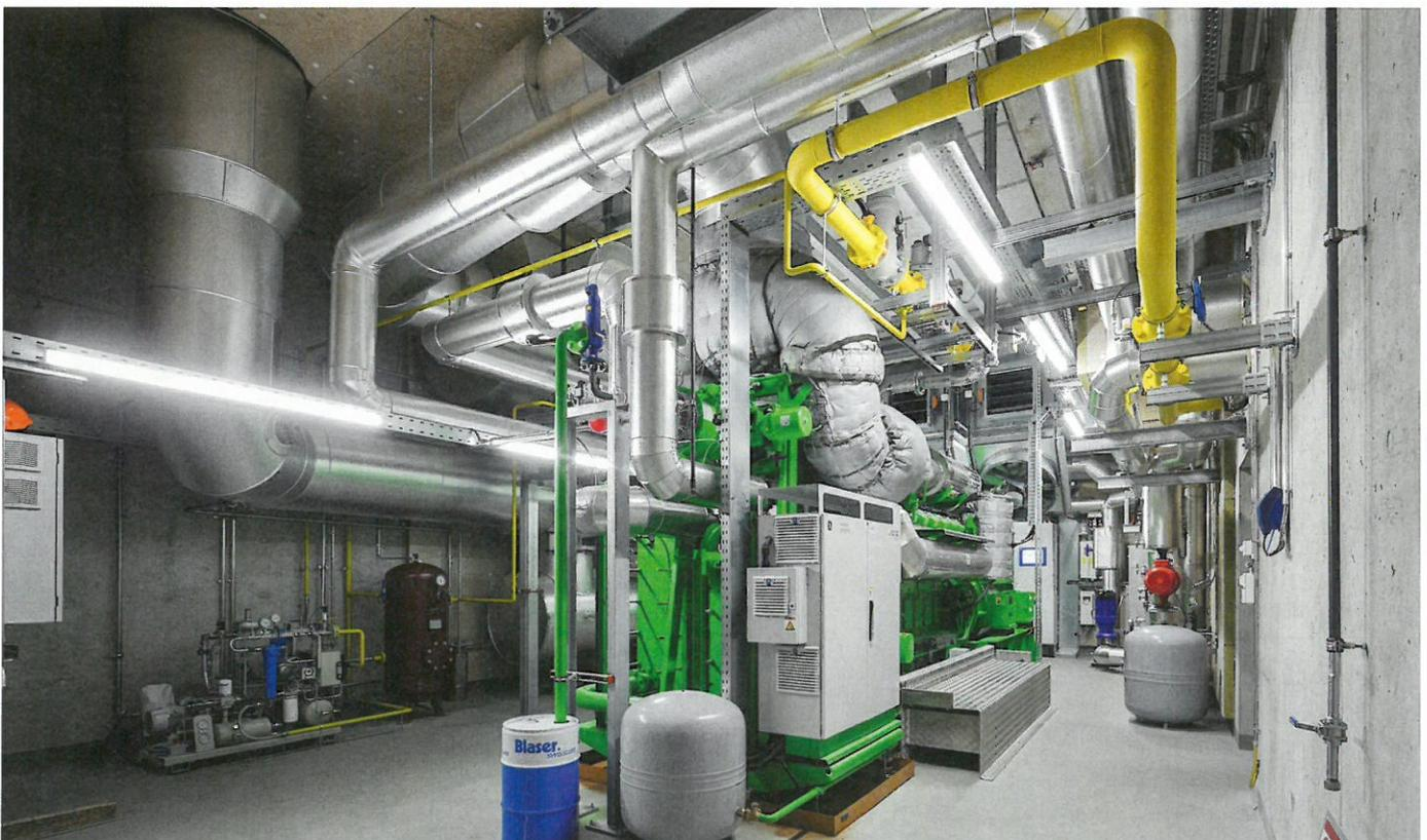
**Abb. 3: Gross-BHKW in der Fernwärmezentrale Au mit 2 MW elektrischer Leistung als wichtiges Element der Sektorkopplung.**
