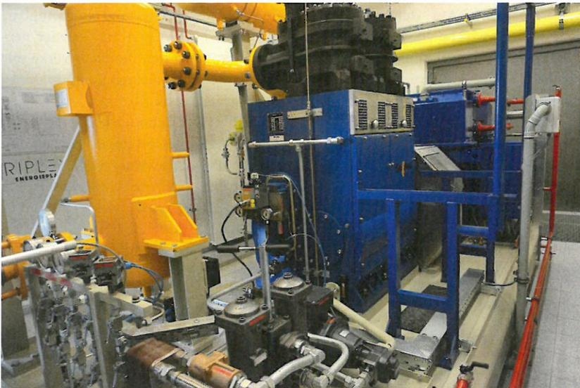
Abb. 6: Erdgas-Druckreduzierstation Hohfirst mit Gasexpansionsmotor von Spilling Technologies (blau, im Vordergrund der Motor, dahinter der Generator): Stromerzeugung durch Energie-Rückgewinnung bei der Gasexpansion.
