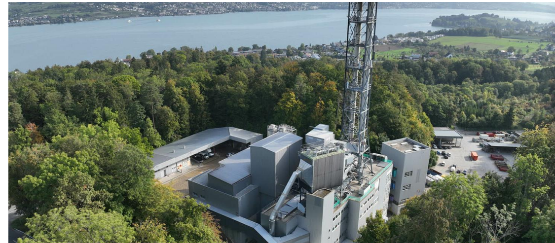
Green Hub: KVA in Horgen
